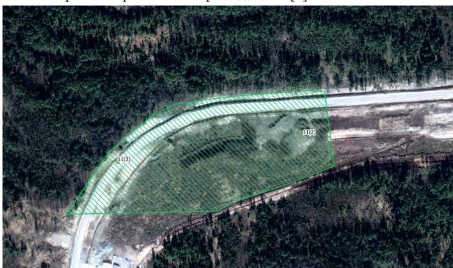
Рис. 8. Заболоченная ПОЗ в районе строительства автодорог, КА WorldView-3
